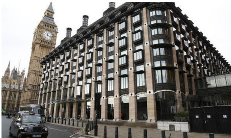
Slika 5. Portcullis House, primjer nikal-aluminijske bronce u arhitekturi [6]
