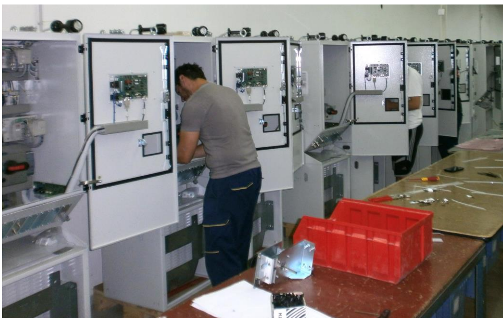
Slika 36. Montaža konačnog proizvoda [22]
