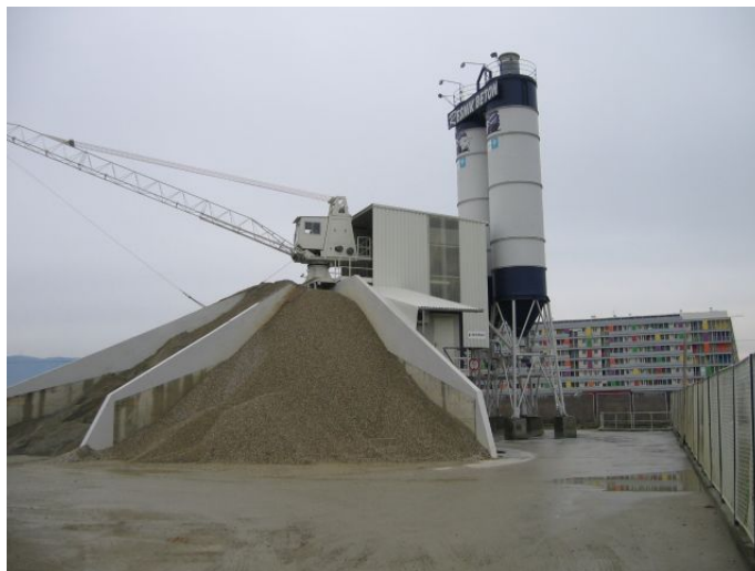
Slika 1. Betonara tipa „zvijezda“
