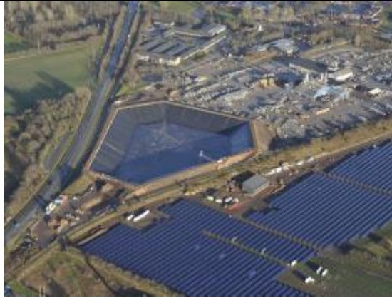
Slika 8. Solarna toplana sa spremnikom topline u Vojensu [10]
