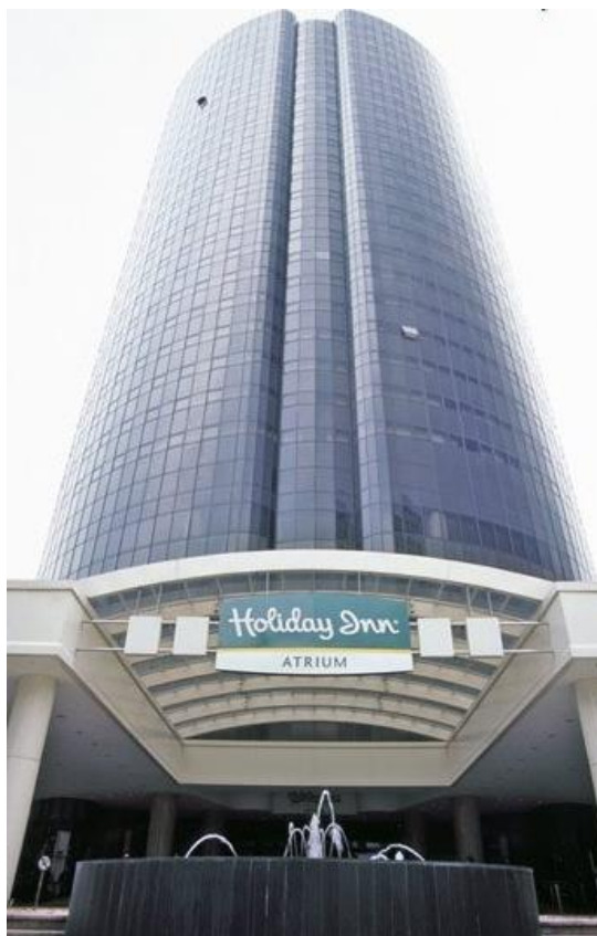
Slika 11. Pročelje Holiday Inn ATRIUM hotela
