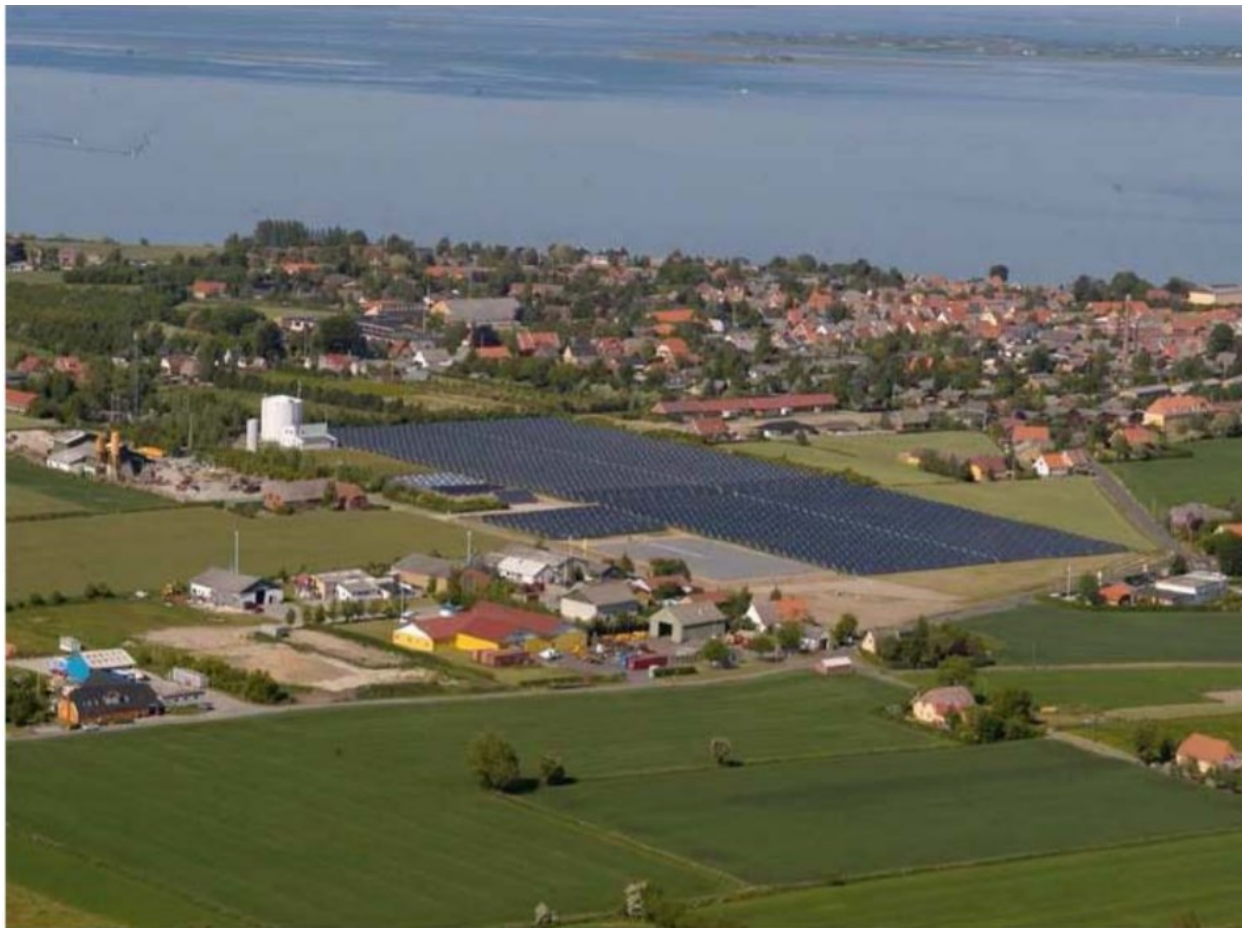
Slika 29: Solarni centralni toplinski sustav gradića Marstal na danskom otoku Aero [53]
