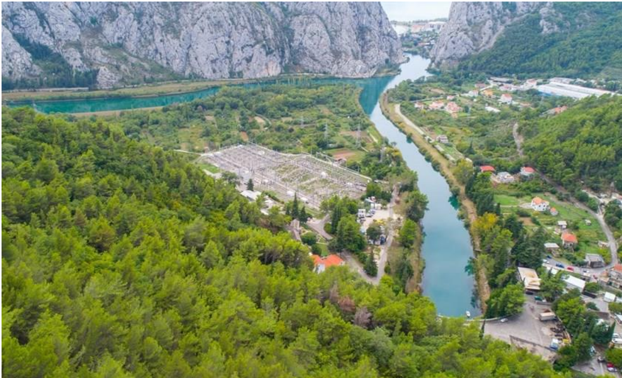
Slika 10. HE Zakučac – rasklopište, odvodni kanal i rijeka Cetina
