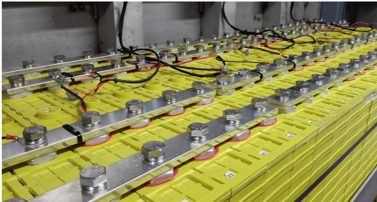
Slika 16. Više ćelija LiFePO<sub>4</sub> baterije spojeno serijski i paralelno da bi stvorili bateriju od 2800Ah i 52V
