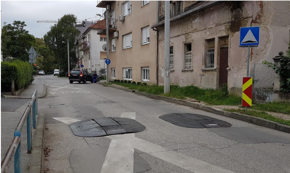
Slika 33. Uzdignuta ploha na Novoj cesti
