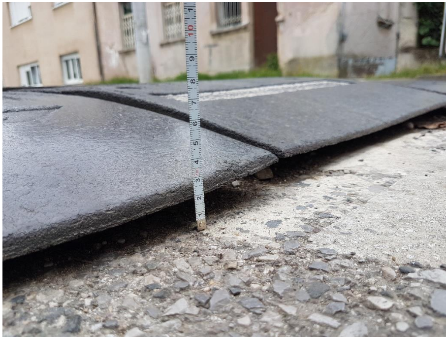
Slika 37. Primjer izdizanja prepreke od kolničkog zastora
