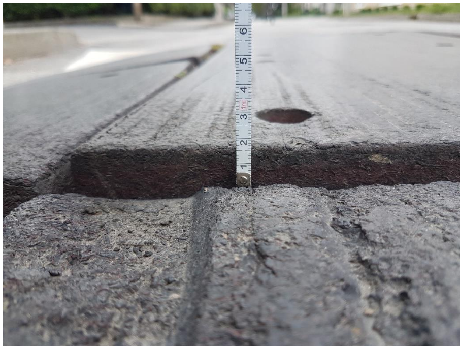
Slika 38. Primjer međusobnog izdizanja gumenih elemenata
