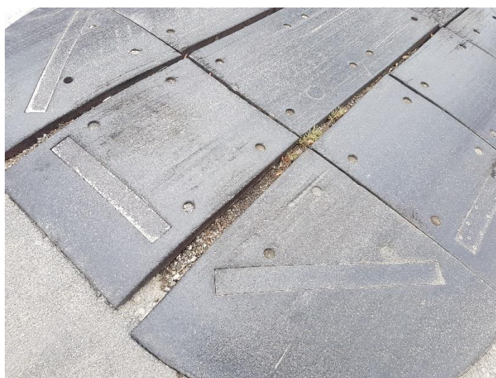
Slika 36. Primjer razdvajanja gumenih elemenata na prepreci na Novoj cesti
