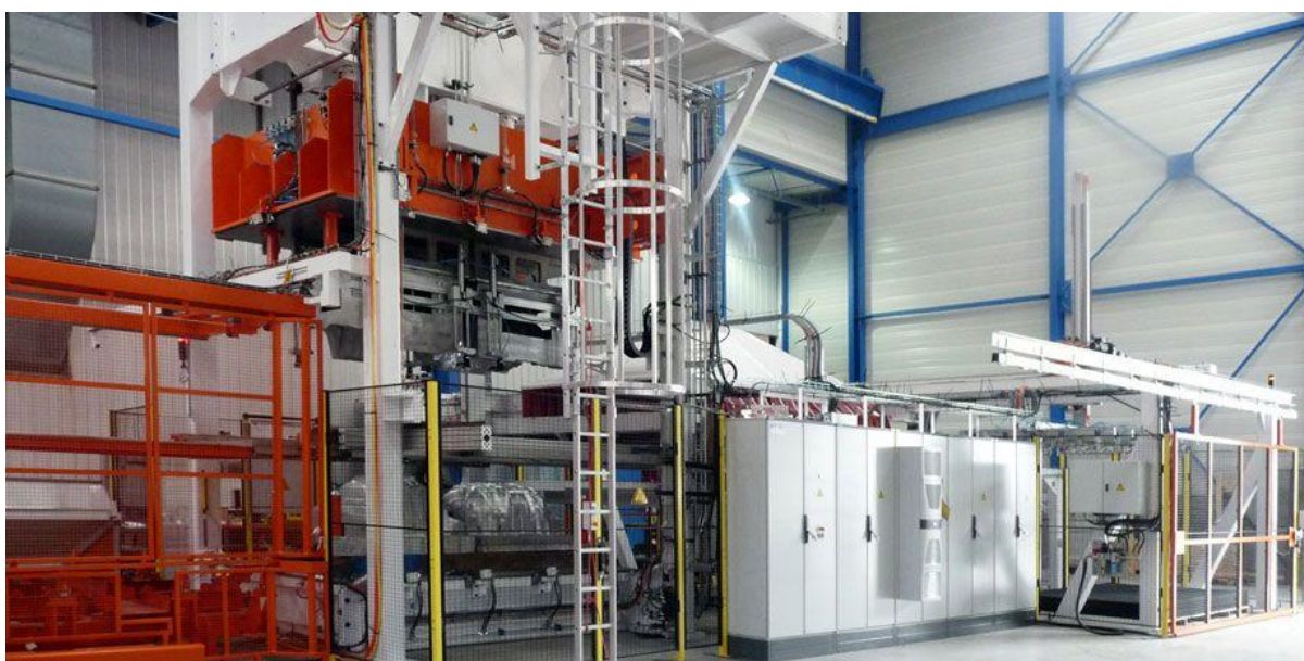
Slika 2. Moderno industrijsko postrojenje za oblikovanje metala deformiranjem [13]
