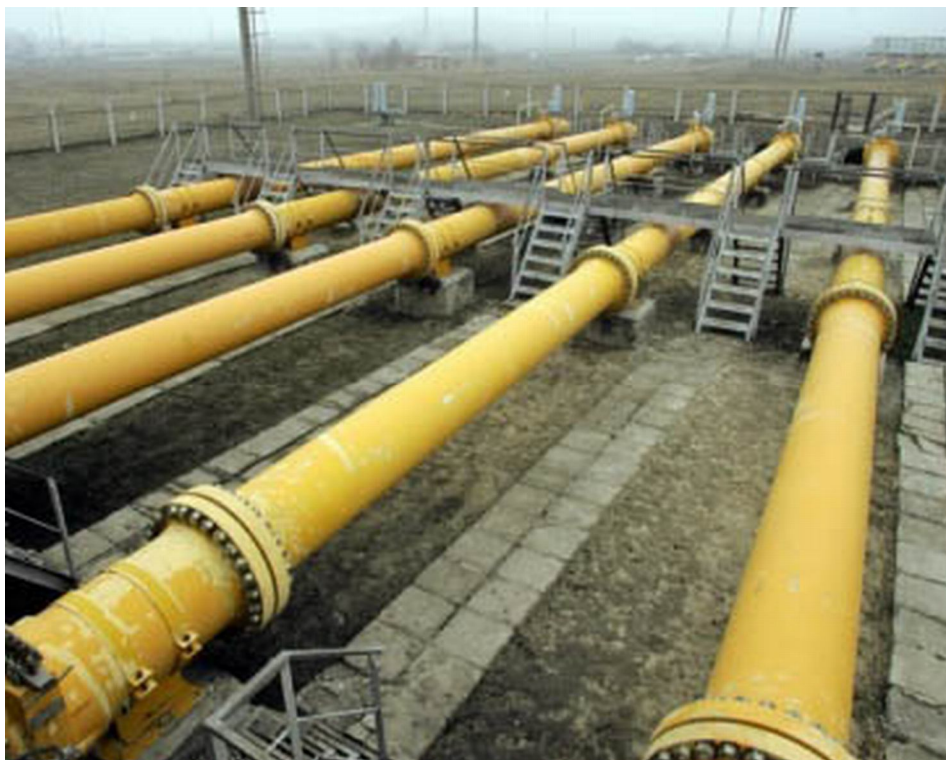
Slika 2.8 - Plinovod za transport UNP-a [1]
