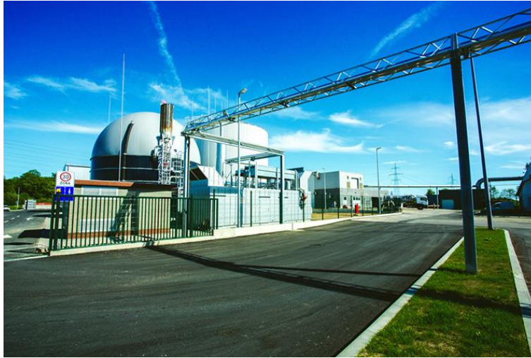
Slika 4.3. Bioplinsko postrojenje (kogeneracijski dio postrojenja)
