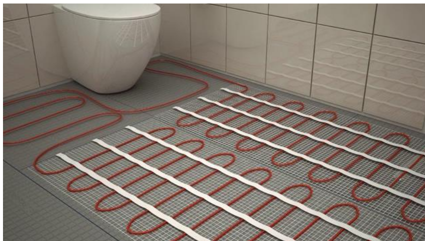
Slika 23. Serpentinasti tip polaganja petlji podnog grijanja
