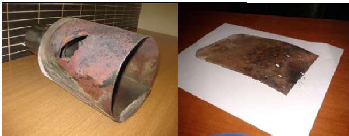
Slika 13. Oštećen plamenik i deformirana rešetka [13]
