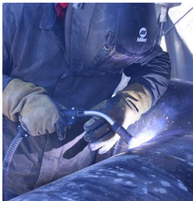
Slika 30. Ručno MAG zavarivanje čeličnih cijevi [8]
