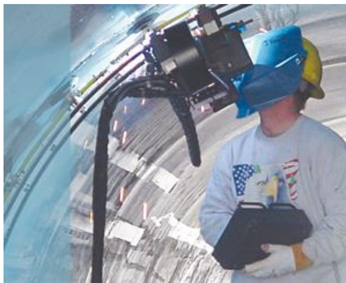
Slika 31. Poluautomatsko FCAW zavarivanje čeličnih cijevi [8]
