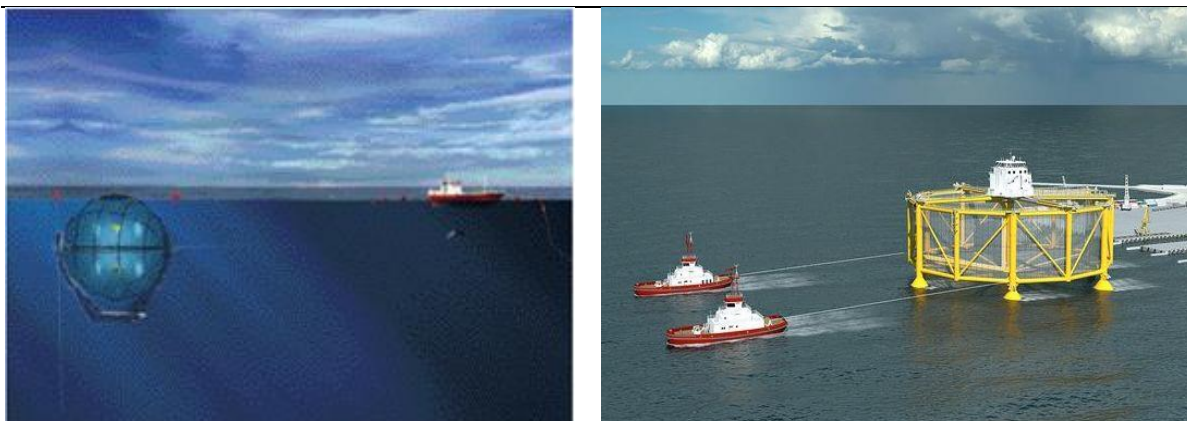
Slika 10. Kuglasti kruti uronjeni ili površinski kavez [2] (lijevo) i klasični čelični plutajući kavez (desno)
