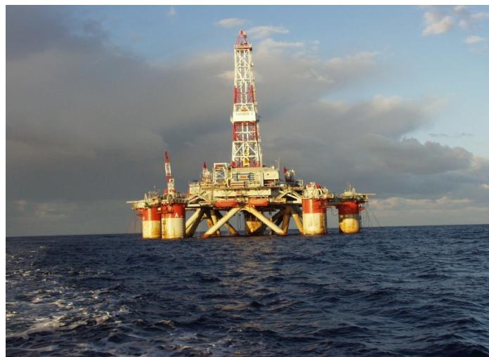
**Slika 2. Pluuronjiva platforma pentagonalnog tipa**
