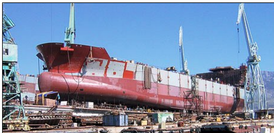
Slika 6.1. Brod STENA PARIS za vrijeme gradnje na navozu [18]
