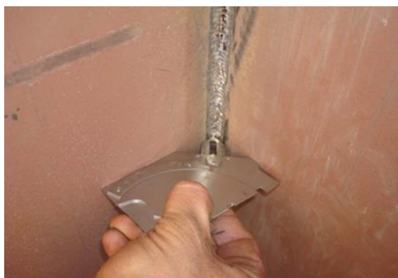
Slika 25. Provjera visine zavara
