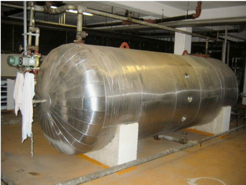
Slika 6. Spremnik PTV-a od 10 000 litara
