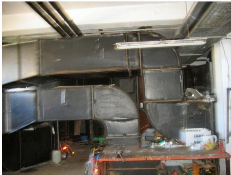
**Slika 5. Kanalski sustav toplozračnog grijanja**
