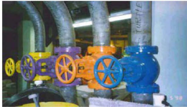
VpCI-375 akrilni premaz koji se primjenjuje kao temeljni i završni premaz u zaštiti od korozije na otvorenom, poluotvorenom ili natkritom prostoru. Kompleksna mješavina neotrovnih, organskih inhibitora i pigmenta aluminija pruža zaštitu koja nadmašuje onu većine boja i osnovnih premaza bogatih cinkom. Pruža optimalni učinak na otvorenom bez pucanja ili ljuštenja premaza nakon dužeg izlaganja sunčevom svjetlu.
