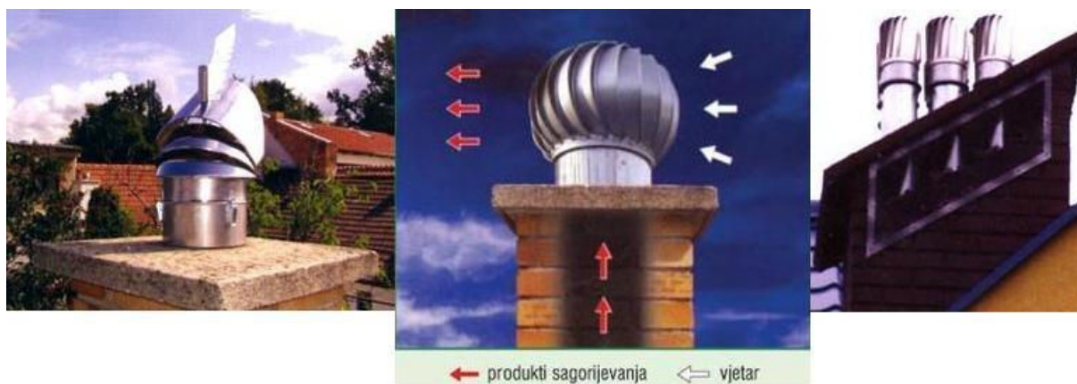
Slika 1.3. Neke od varijacija kapa za dimnjake
