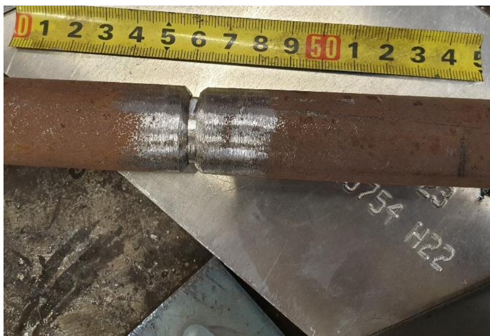
Slika 14. Pripremljene cijevi za zavarivanje čeonog spoja
