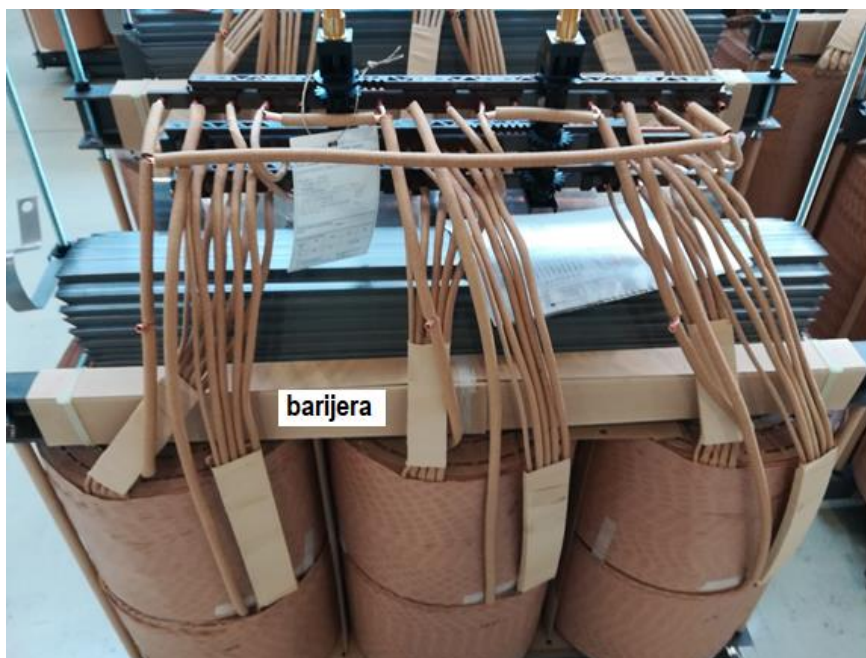
Slika 25. Montirana barijera na metalni steznik DT-a
