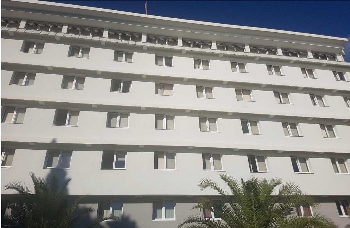
Slika 6.1 Prikaz otvorenih prozora na južnom pročelju zgrade gradske uprave Grada Kaštela (prosinac, 2018.)
