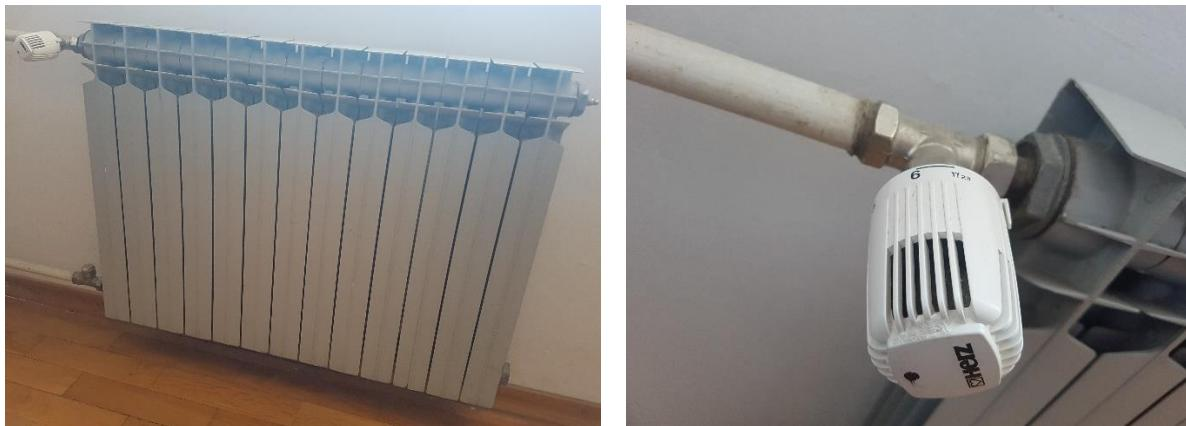
**Slika 3.4 Ogrjevna tijela u prostorijama zgrade (lijevo) i ugrađeni termostatski ventili (desno)**
