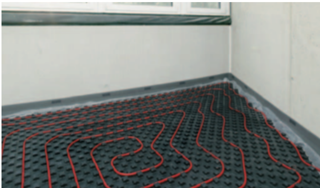
Slika 22. Podni sustav s čepovima – REHAU [8]
