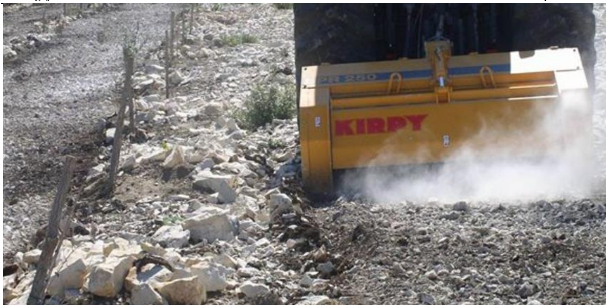
Slika 2. Postupak usitnjavanja kamena
