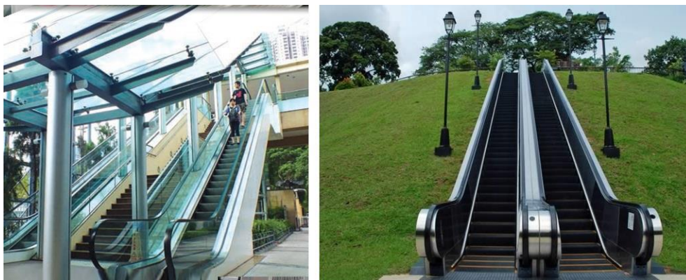
Slika 2. Polu-vanjska i potpuno vanjska izvedba pokretnih stepenica [3],[4]
