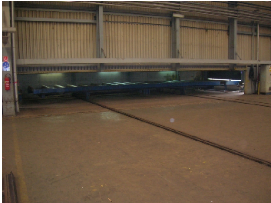
Slika 7. Poprečna rampa za unos limova u halu
