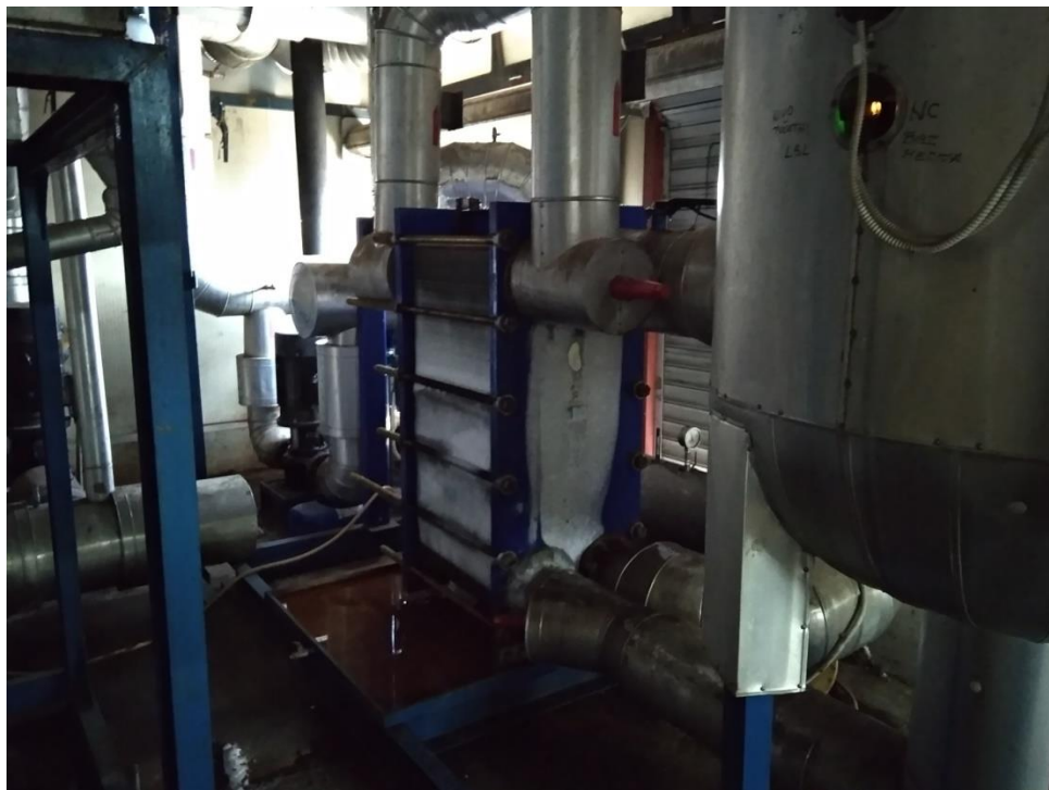
Slika 6. Pločasti izmjenjivači topline
