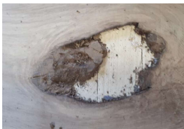
Slika 4. Primjer nepravilnosti površinskog sloja parketa
