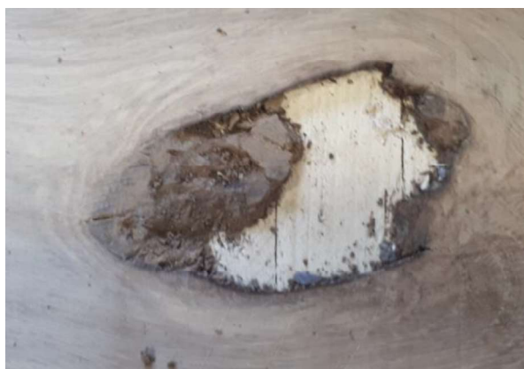
Slika 4. Primjer nepravilnosti površinskog sloja parketa
