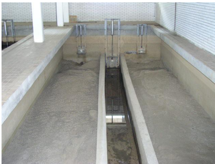
Slika 1.1 Prikaz jednog od filtracijskih bazena u postrojenju za dobivanje pitke vode tvrtke Vodoopskrba Kupa d.o.o.
