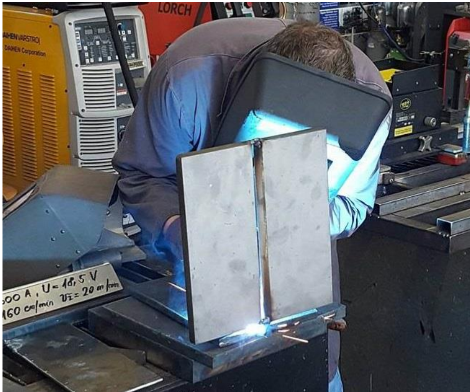
Slika 35. Pozicioniranje u vertikalni položaj i zavarivanje pripoja
