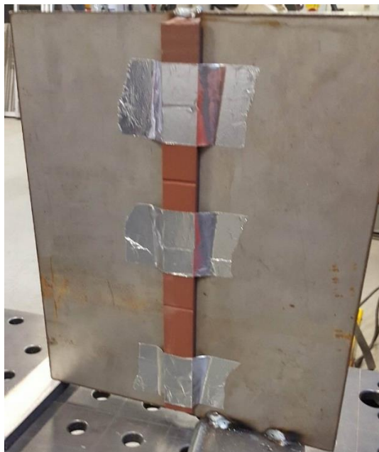
Slika 36. Postavljanje keramičke podloge
