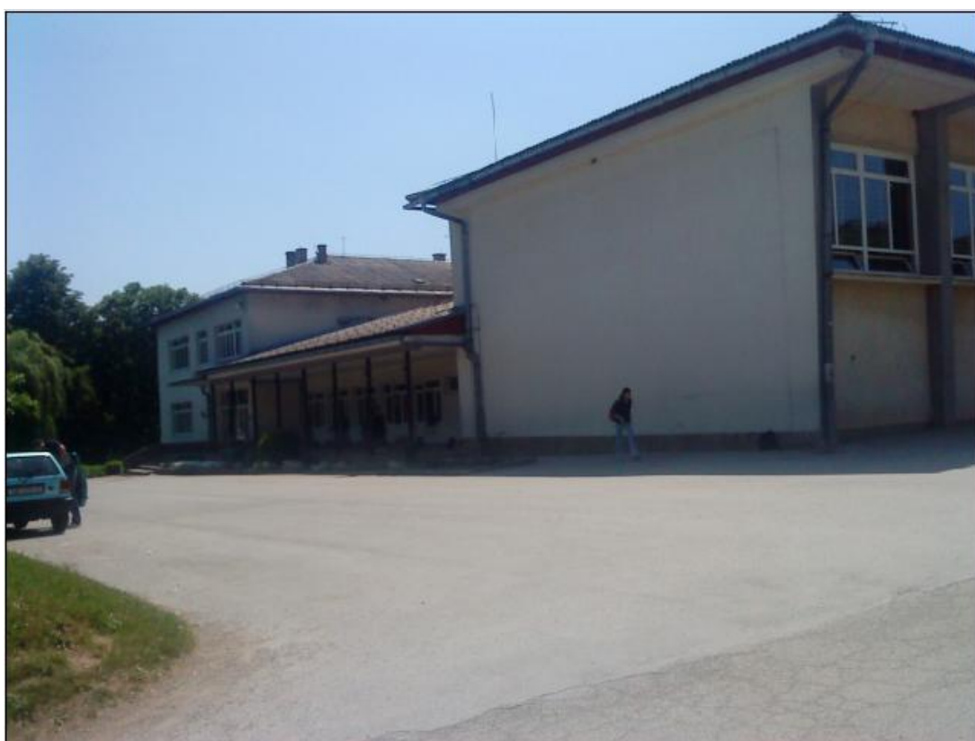
Sl.20. Školska zgrada s dvoranom
