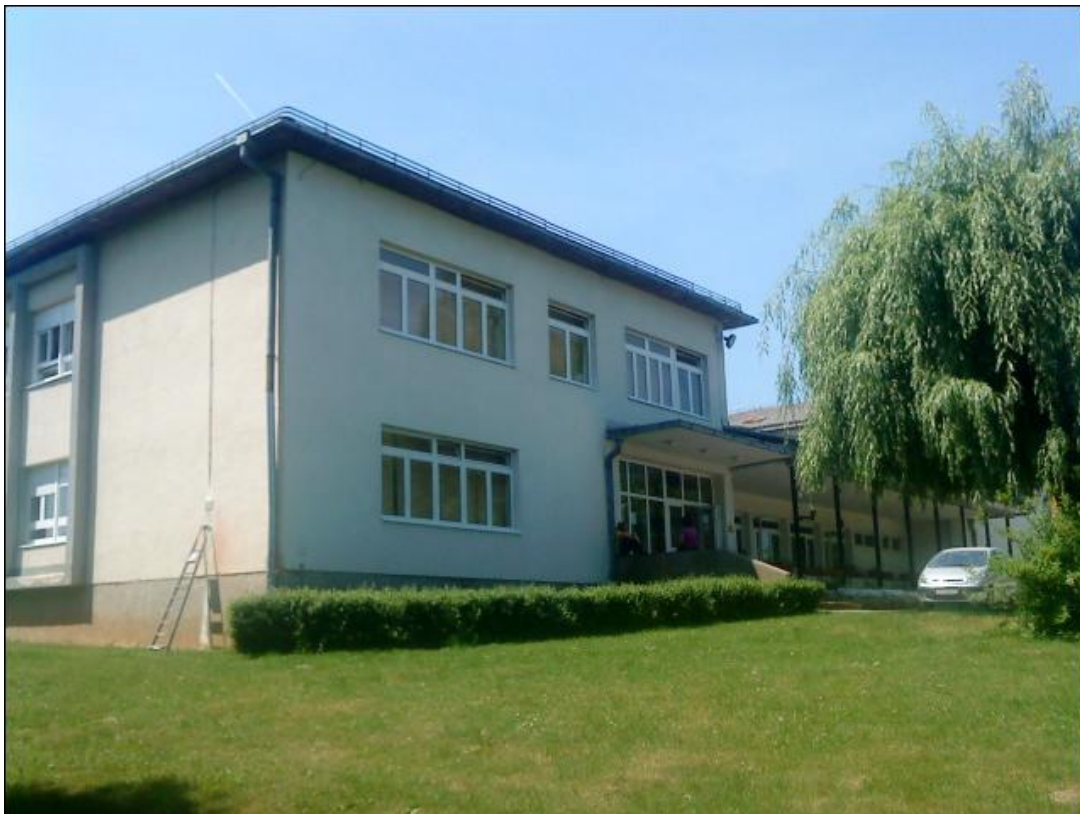
Sl.18. Pročelje Osnovne škole Eugena Kvaternika Rakovica
