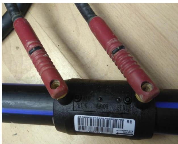
Slika 35. Elektrofuzijsko zavarivanje
