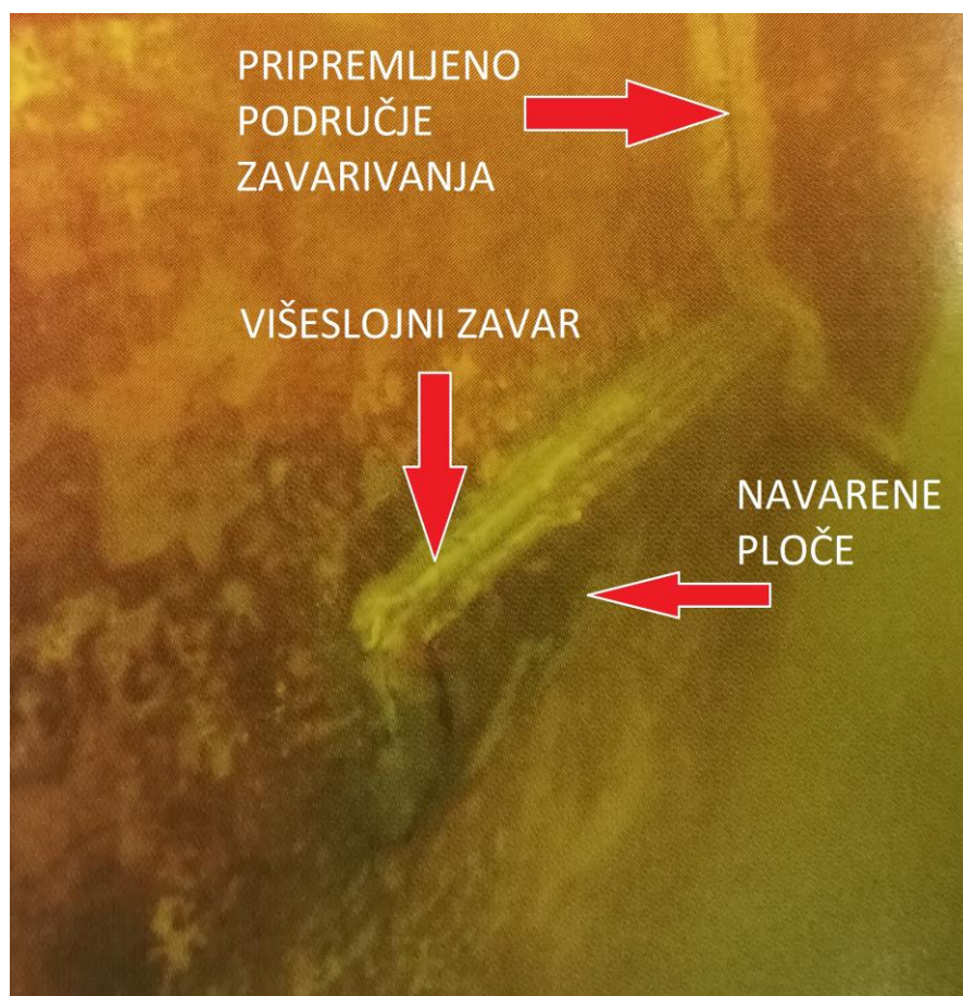
Slika 27. Stanje nakon izvršenih popravaka [15]
