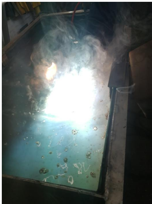
Slika 42. Zavarivanje pod vodom
