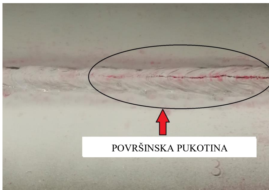
Slika 56. Pukotina na zavaru izvedenom elektrodom EZ KROM 30R
