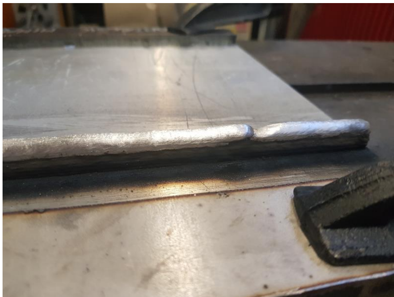
Slika 30. Nepravilnost zavora pri izradi zida 1
