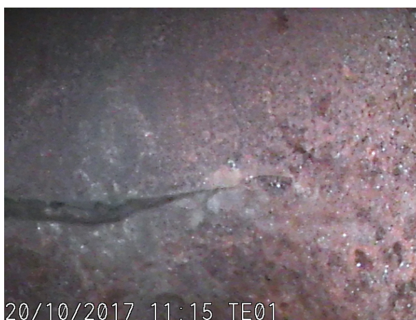
Slika 17. Početak pukotina
