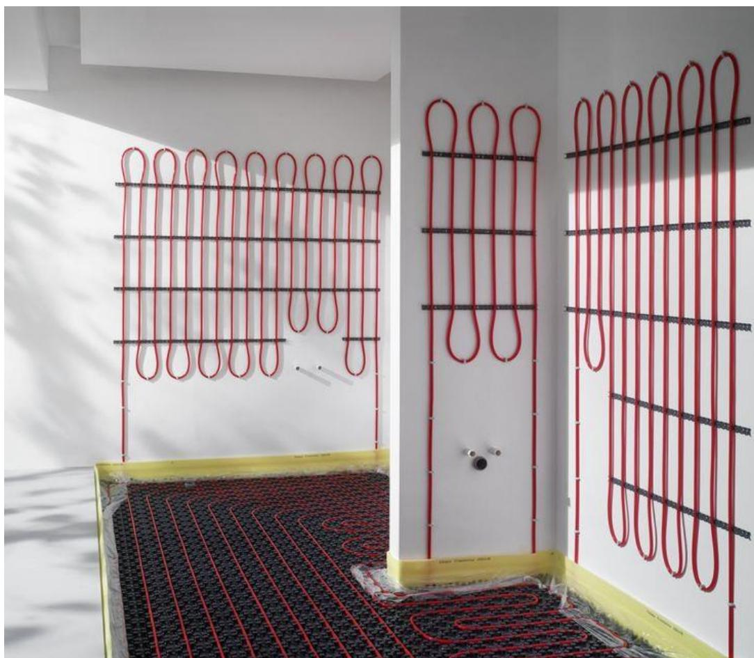
**Slika 1.4 Izvedba panelnih grijaca**
