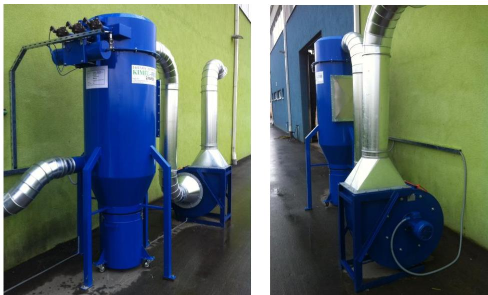
**Slika 16. Ciklon i filter s vanjske strane pogonske zgrade**
