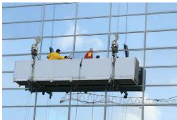
Slika 1. Platformsko čišćenje prozora
