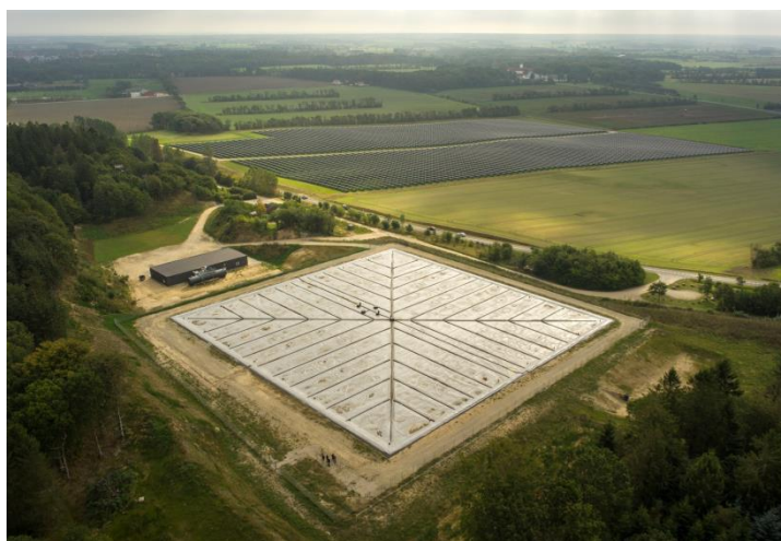
Slika 11. Sezonski spremnik topline i kolektorko polje u pozadini [22]
