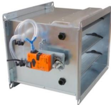
Slika 12. Regulator varijabilnog protoka zraka RVP-P [2]
