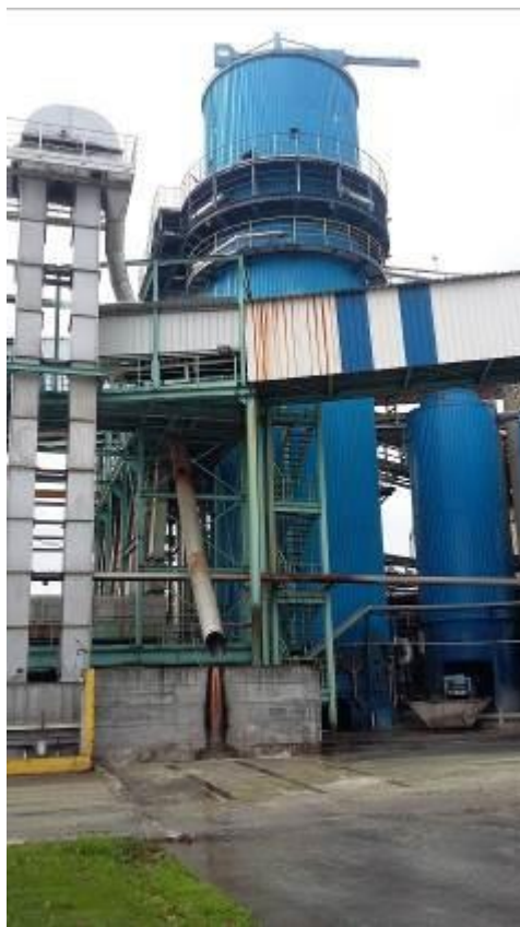
Slika 10. Vertikalni difuzni toranj [10]
