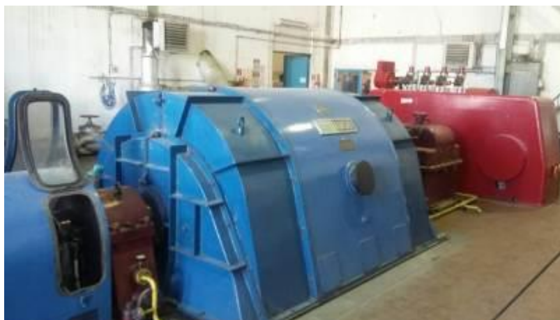
Slika 21. Parna turbina u energani tvornice šećera [10]
