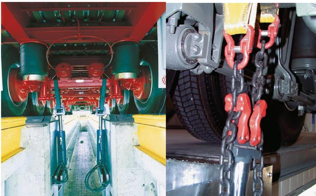
Slika 10. Povlačenje osovine sa hidraulikom[8]
