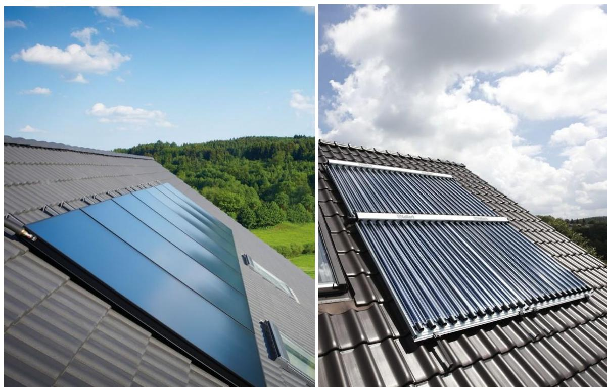
**Slika 2.10. Lijevo – pločasti kolektori auroTHERM VFK 145 V,
