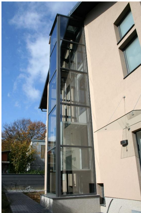
Slika 18 Prikaz oslonjenog fasadnog dizala sa staklenom ispunom
