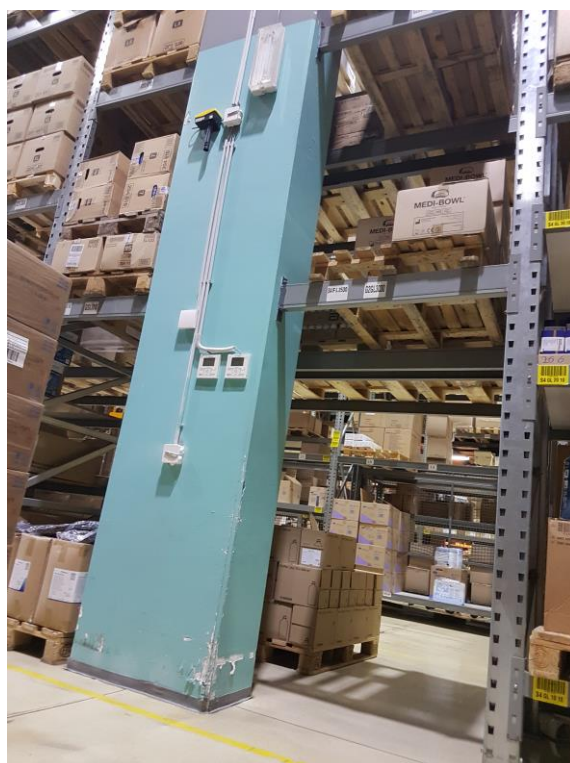
Slika 5.25. Noseći stup na predviđenoj novoj skladišnoj lokaciji
