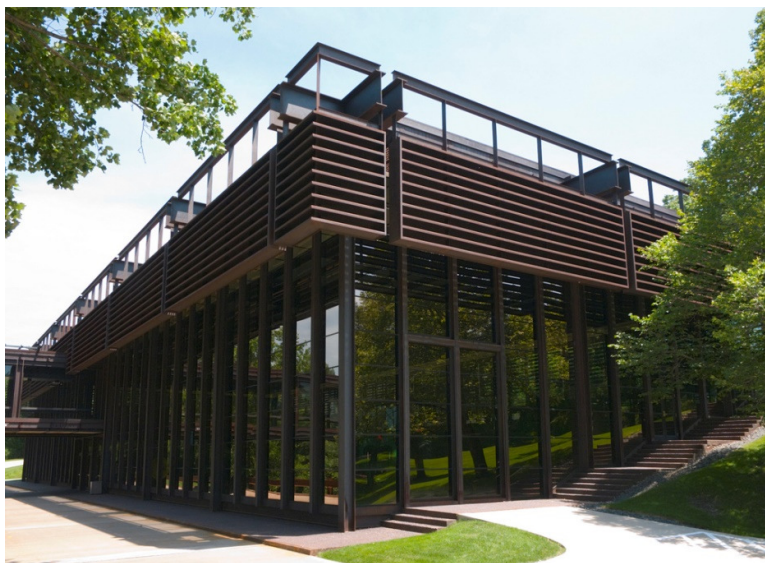
Slika 7. Primjena Corten čelika [33]
