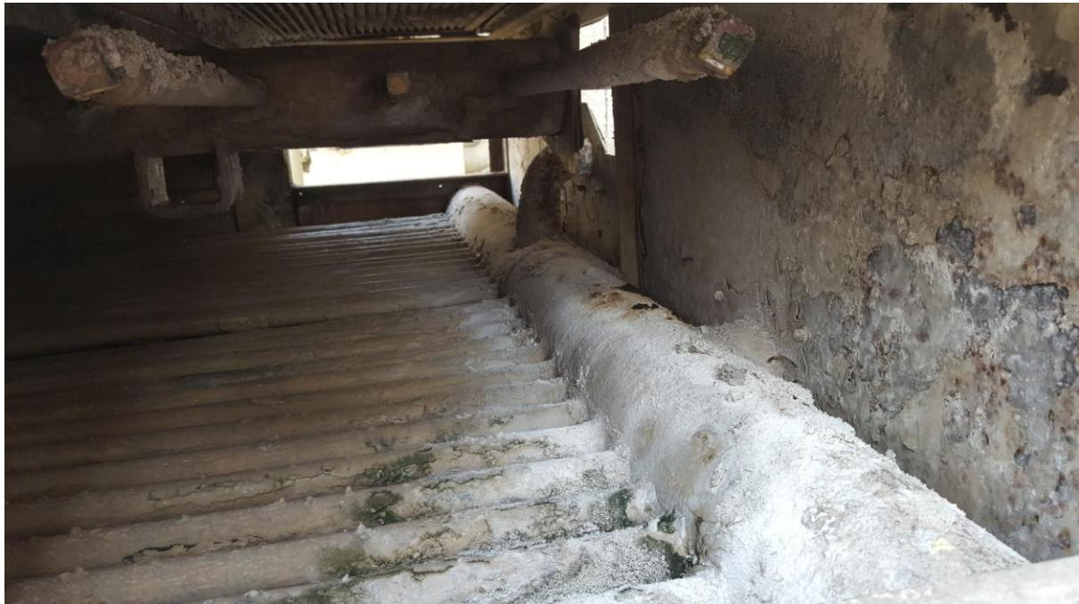
**Slika 6. Kamenac u evaporativnom kondenzatoru**
