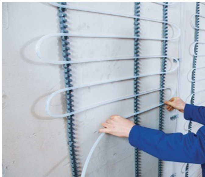
Slika 9. Postavljanje 'Uponor Minitec' sustava zidnog grijanja
